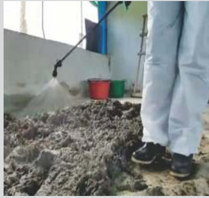
Figura 4. Aplicación del tratamiento
